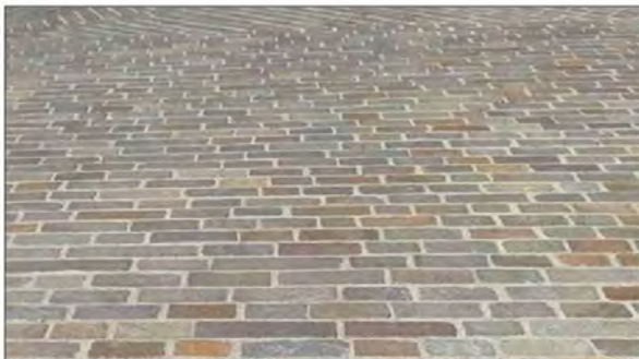
Esempio di pavimentazione in lastre di porfido rettangolari con disposizione a file parallele "a correre"
