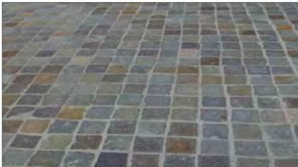
Esempio di pavimentazione in cubetti in porfido con disposizione a file parallele "a carrè". Dimensione cubetti: 8 / 10 cm
