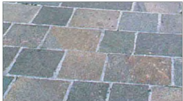
Esempio di pavimentazione in lastre di porfido rettangolari e quadrate con disposizione a file parallele "a correre"
