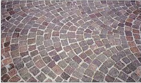
Esempio di pavimentazione in cubetti in porfido con disposizione a coda di pavone (o a ventaglio). Dimensione cubetti: 8 / 10 cm
