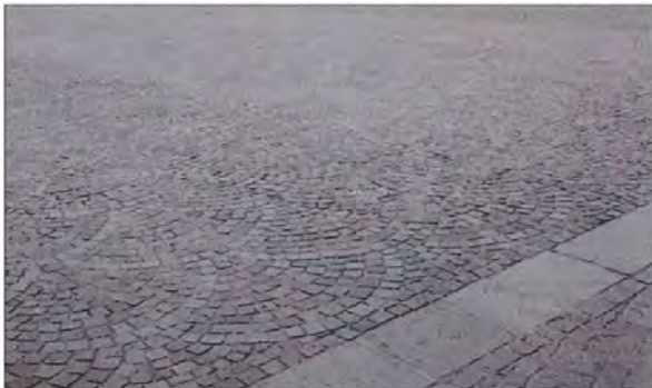
Esempio di pavimentazione in cubetti in porfido con disposizione a coda di pavone con interposta fascia cromatica di bordo
